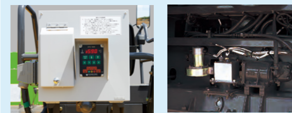
コントロールボックス
